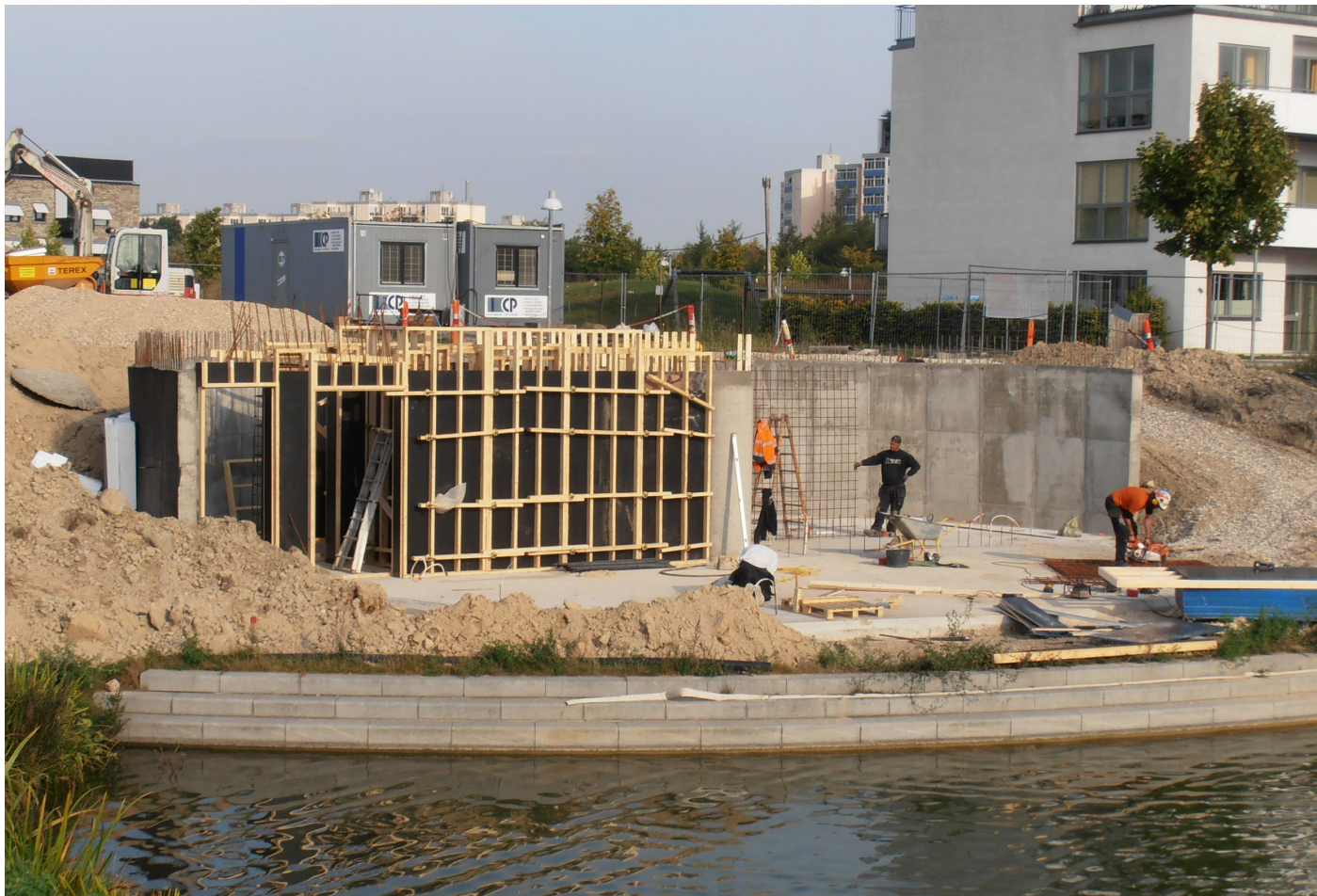
Byggeriet d. 26. september 2016.
